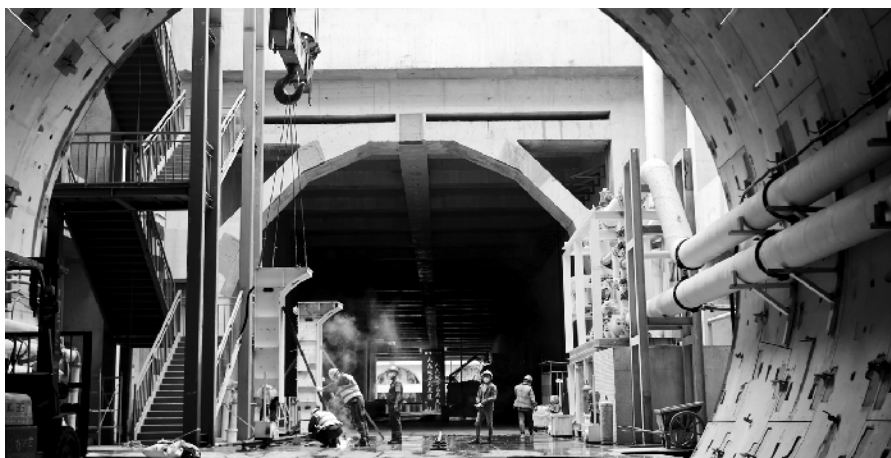
5 月 28 日，在中铁隧道局上海机场联络线 11 标段复工施工现场，工人在转换井内施工。 新华社发
