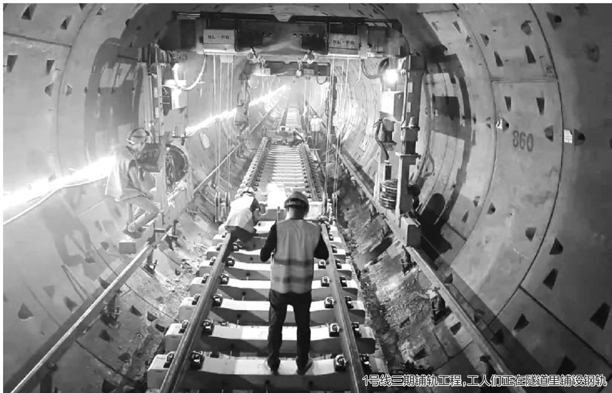
1号线三期铺轨工程,工人们正在隧道里铺设钢轨
