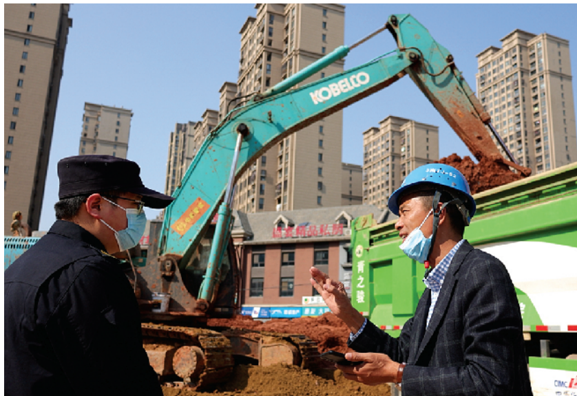
叶浩(左)在工地检查渣土运输
