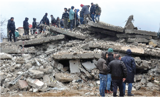
2月6日,在叙利亚拉塔基亚省杰卜莱,人们在一处倒塌的建筑现场进行救援。 新华社发
